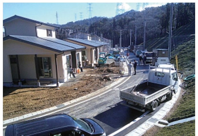
建設が進む現地の様子
