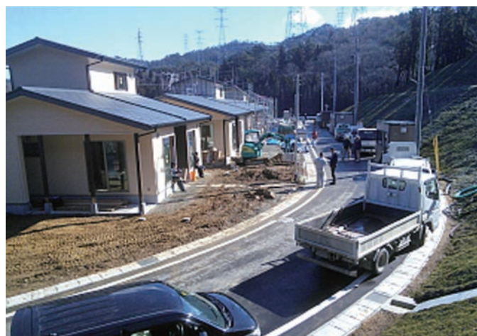
建設が進む現地の様子
